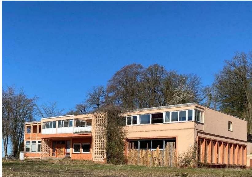
Foto 18: Verwaister Gebäudekomplex an der Fuldaer Straße
