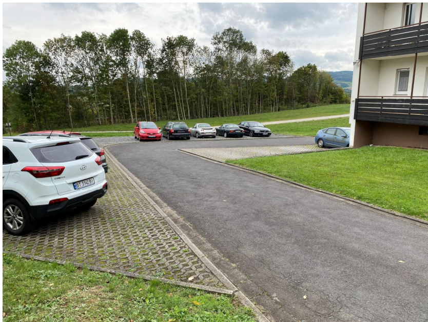
Foto 16: Stellplätze mit Rasengittersteinen und Schotter (Hintergrund)
