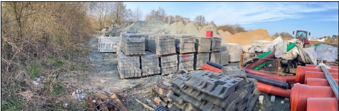
Abbildung 5: Blick über das Grundstück von Südwesten her, Blick-RI NO (03/2026)
