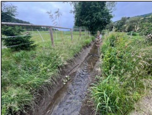
Abbildung 8: Mühlgraben, Blick nach Nordwest - eig. Aufn. 06/2025
