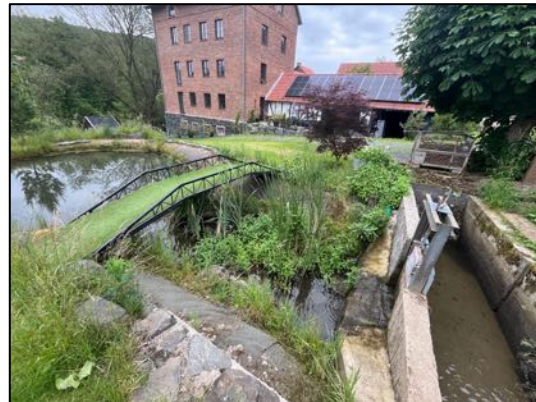
Abbildung 9: Überlauf Mühlgraben mit gestaltetem Rückhalte-Teich - eig. Aufn. 06/2025
