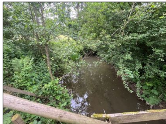
Abbildung 11: Auslauf der Turbinenanlage - eig. Aufn. 06/2025
