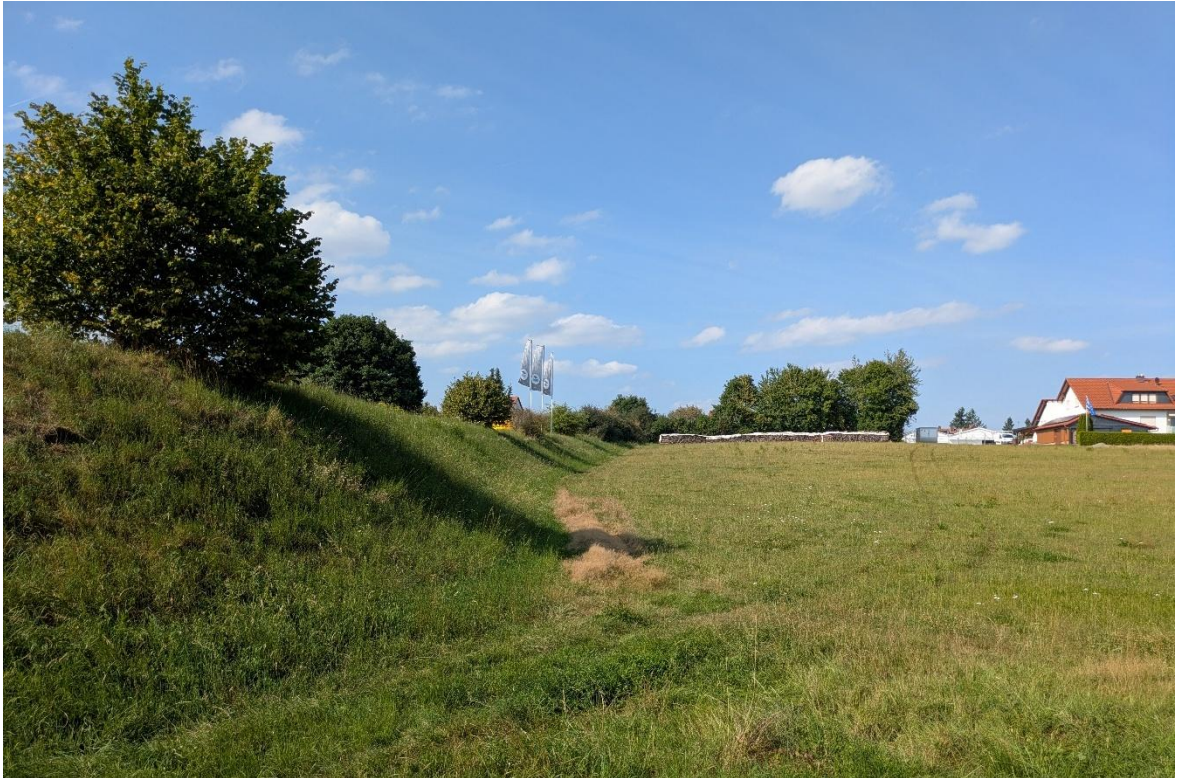
Abbildung 2: Blick von der Zufahrt im Südwesten entlang des Lärmschutzwalls nach Norden.
