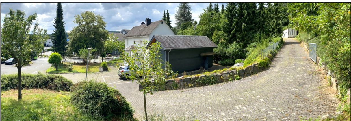
Abbildung 4: Blick auf das Wohngebäude vom Streuobstbestand aus (07/2026)
