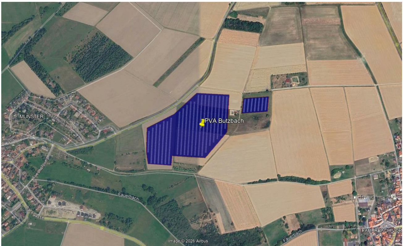
Bild 2.2: Luftbild der PV-Anlage (Quelle: Google Earth / SolPEG)
