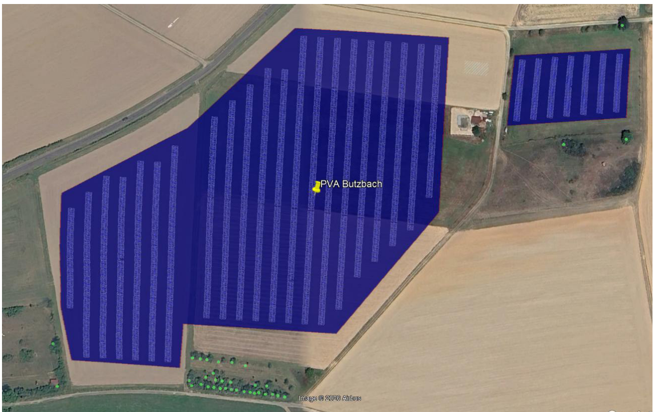
Bild 2.3: Luftbild der PV-Anlage (Quelle: Google Earth / SolPEG)
