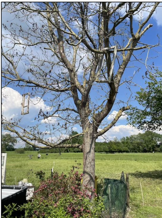
Abbildung 9: Baumruine außerhalb des Geltungsbereichs
