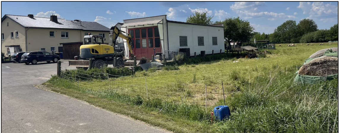
Abbildung 6: Bestandsgebäude im Süden, Blick RI NW
