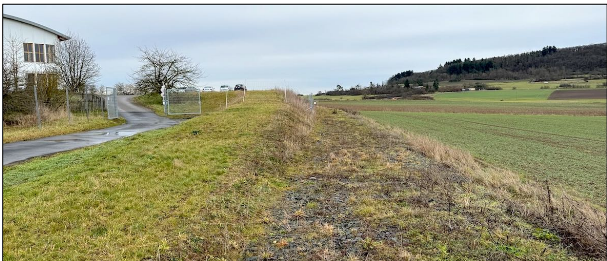
Abbildung 4: Bahndamm nach Herstellung des Schotterwegs und der Geländeauffüllung der südl. Gewerbefront (2025)
