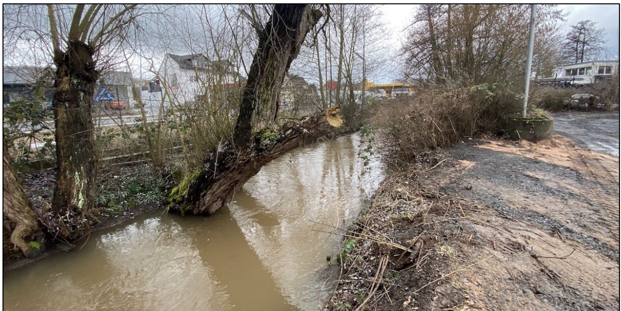
Abbildung 4: Mühlenwohra gegen die Fließrichtung mit freigeschobener Frostschutzdecke des Firmengeländes
