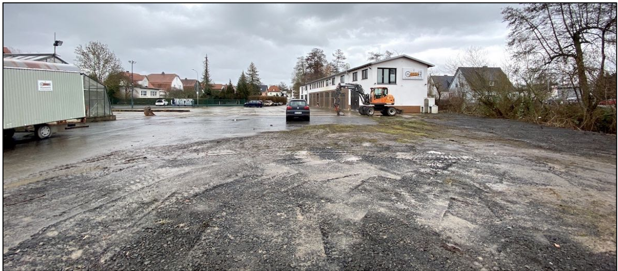
Abbildung 2: Teilrückgebautes Firmengelände links der Mühlenwohra (Blick nach Osten)
