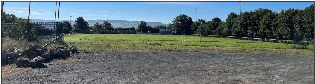
Abbildung 4: Sportplatz im Rückbau, Blick-RI SO (09/2023)
